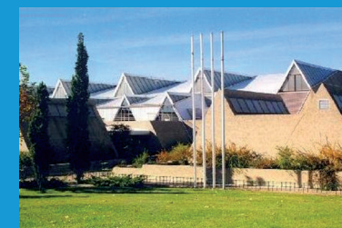
Pabellón 2: Polideportivo Municipal de Entremontes
